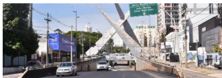
Estimativa é que trabalho seja concluído até 30 de agosto. Obras situadas nos cruzamentos serão realizadas aos finais de semana
