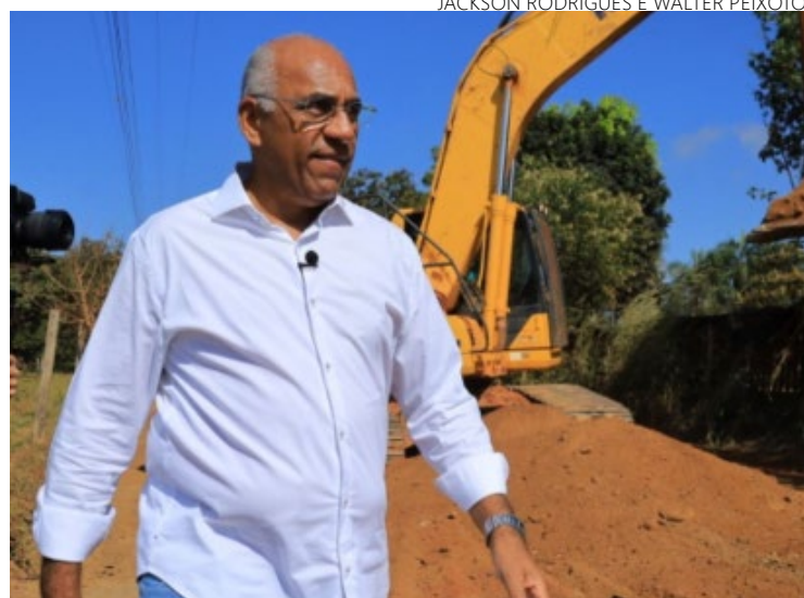
Prefeito Rogério Cruz durante visita ao canteiro de obras em rua do setor Buena Vista na manhã de quarta-feira
